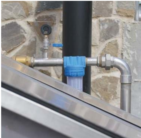
Filtro del sistema di controlavaggio Counter washing system filter
